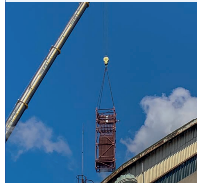
在马赛工地，一台吊车正从锅炉房顶安装过热器锅炉
