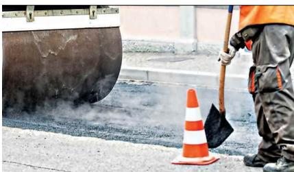
**9.** 在铺设道路时，Cecabase RT® 添加剂可使沥青流态化。因此只需用较低温度加热沥青，降低能耗：
